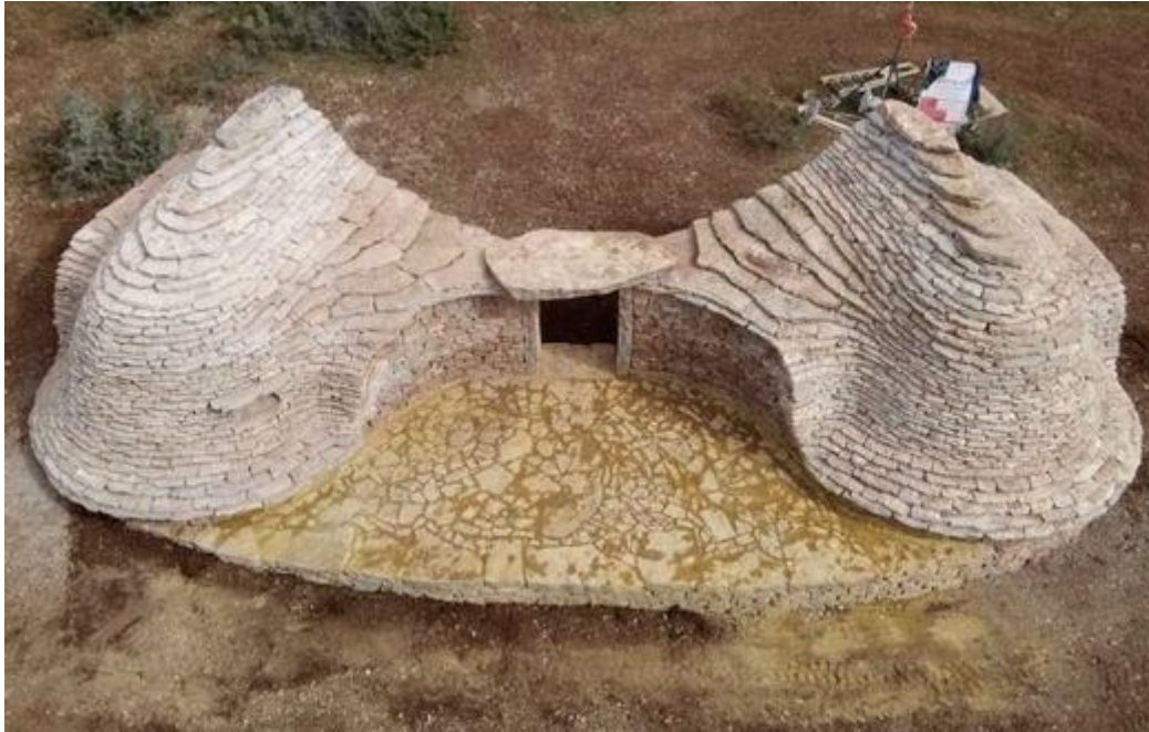
L'abri destiné aux pèlerins de Saint-Jacques Marie la lauze en couverture et les murs en pierre sèche
